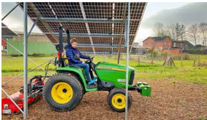
Je nach Aufständigung bieten die Module Arbeitsbreiten von 3 oder 4 m. Fotos (4): Sunfarming
