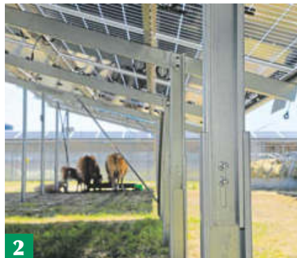
1 Weidezaunlitzten unter Strom garantieren, dass sich nur Kälber unter die niedriger aufgestellten Module stellen können. 2 Schlitzlöffel für die Schraubverbindungen und ein Baukastenprinzip lassen einen sehr individuellen Aufbau zu. 3 Auch Hühner fühlen sich unter Agri-PV sichtlich wohl.
