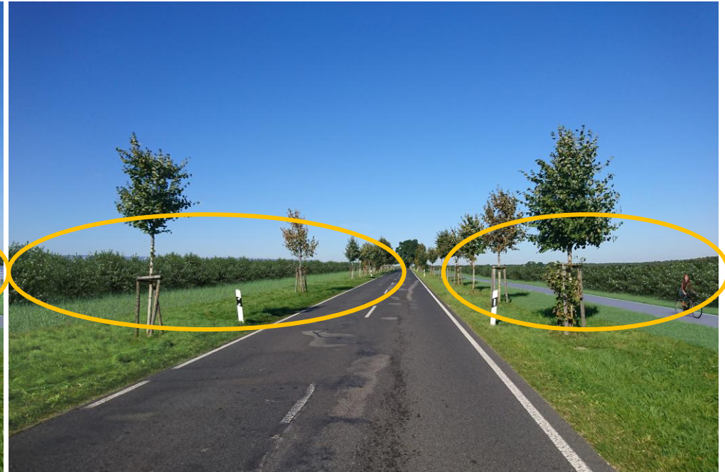
Solarpark mit ökologischem Sichtschutz
