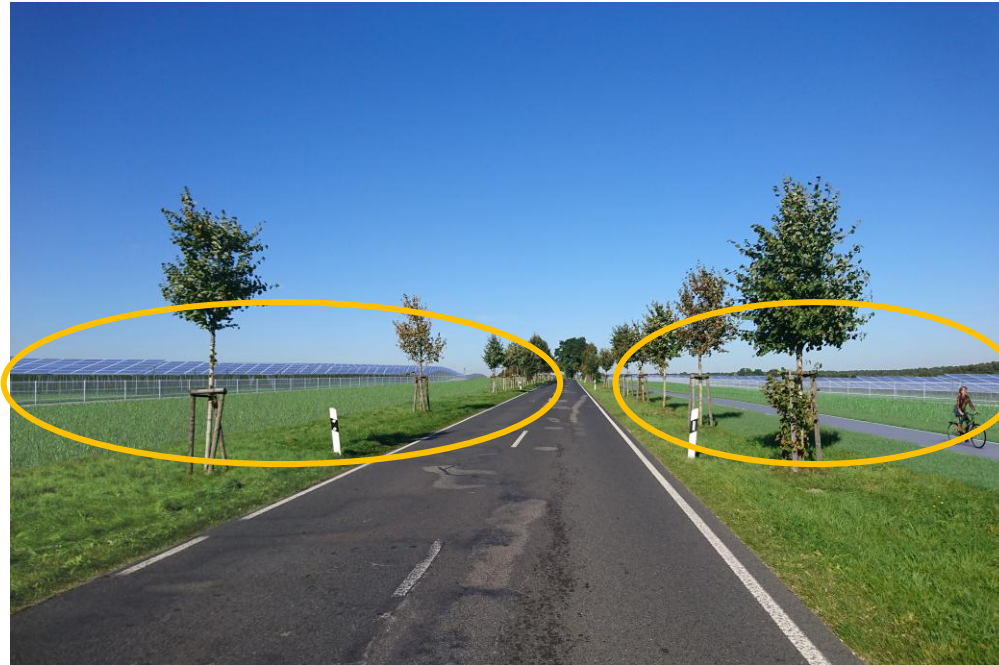
Solarpark ohne ökologischen Sichtschutz
