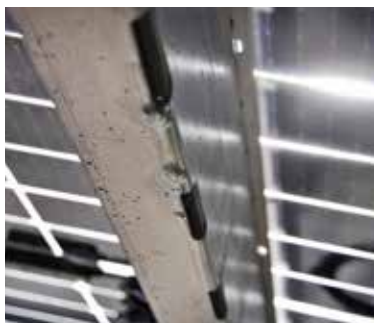
Durch Langlöcher in den C-Profilen wird das Regenwasser querverteilt. Die Module lassen etwa 15 % Licht durch. Foto: Julian Haase
