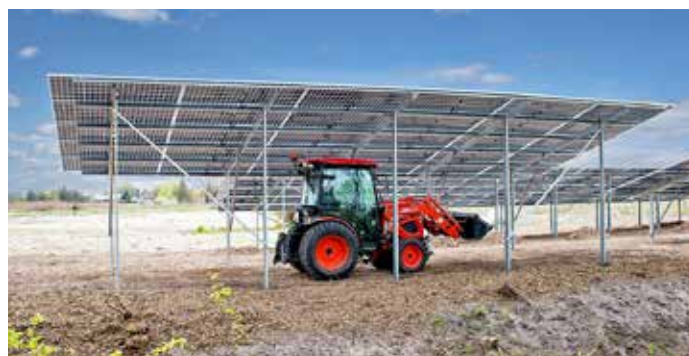
Kommunalschlepper können sich mit Kabine unter den unterfahrbaren Modulen bewegen.
