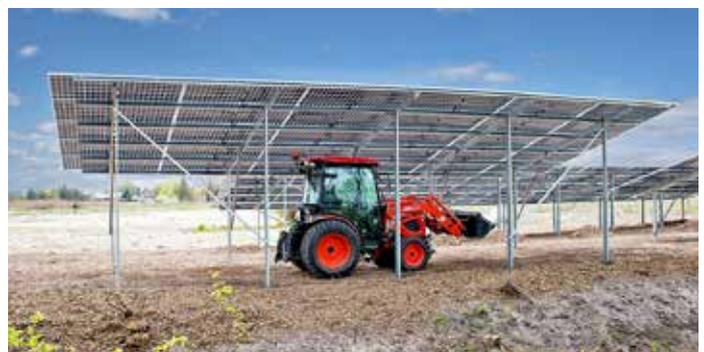
Kommunalschlepper können sich mit Kabine unter den unterfahrbaren Modulen bewegen.
