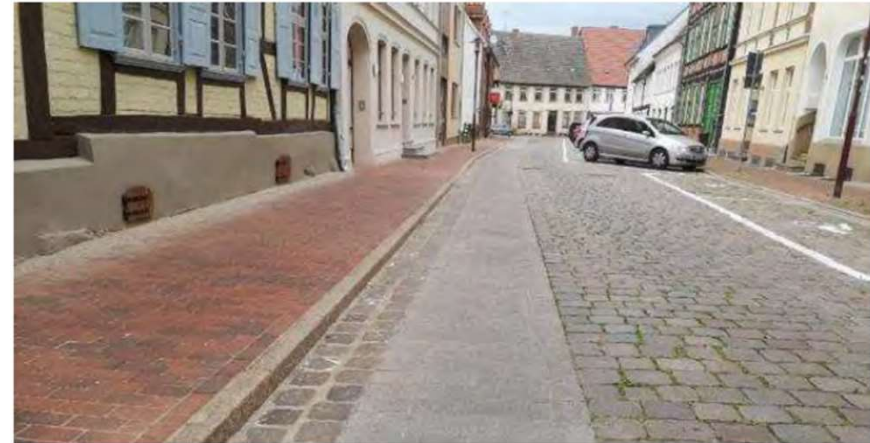
Foto24: verbesserte Oberflächenbeschaffenheit für den Radverkehr in Parchim
