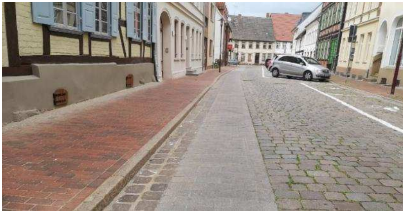
Foto24: verbesserte Oberflächenbeschaffenheit für den Radverkehr in Parchim
