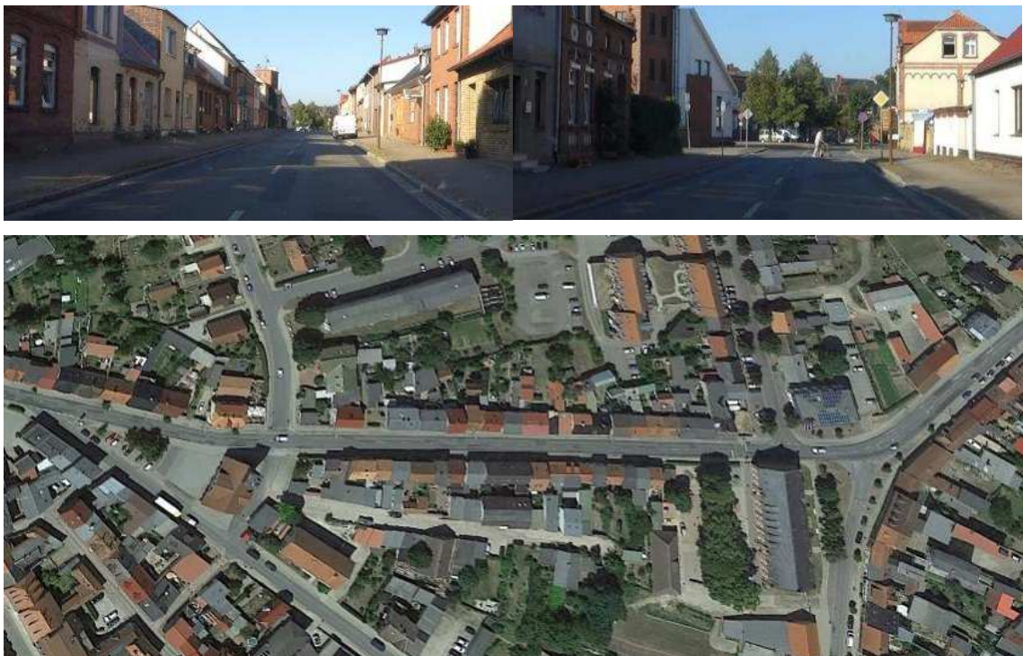
Fotos: Straßenraum Schulstraße (Blickrichtung Osten)/Grafik 18: Orthofoto Schulstraße 17
