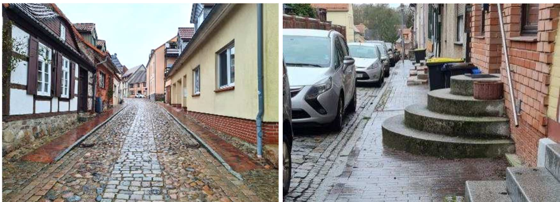
Fotos: Mangelhafte Gehweganlagen
