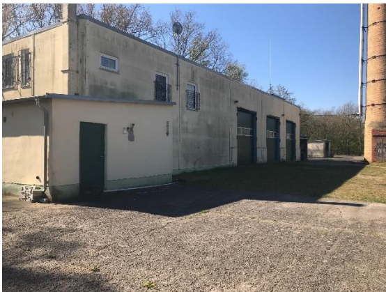
Abbildung 23 Gerätehaus 2 (Depot) Tore
