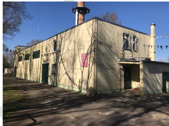
Abbildung 24 Gerätehaus 2 (Depot) Eingang
